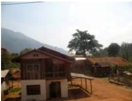
蓄財による改築・高床にレンガ積で部屋を。 到る処で改築・増築工事が見られることとなる
