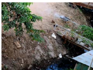
←ホテル裏の排水路。 下水はまだまだ夢物語
