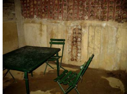
↑地下壕内部の部屋。
