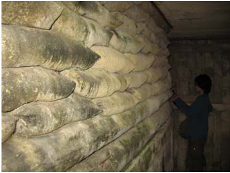
←地下壕内部の壁。土嚢にセメントが詰め込まれたもので構築されている。史実かは不明。
