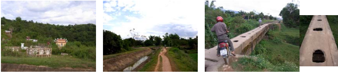
↑ 左手に集落墓地を見ながら水路堤を進む。穴の開いた暗渠をバイクが進みます。
